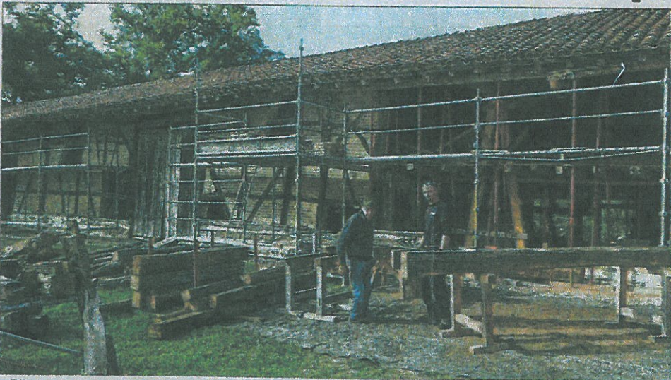
■ D'importants travaux sont en cours. Photo Jacques SAVERET
